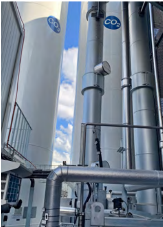
In der geplanten CO 2 -Abscheidungsanlage wird das Kohlendioxid vom Methan getrennt, dann verflüssigt und für den Transport in Tanks abgefüllt. Foto: HZI BioMethan GmbH
