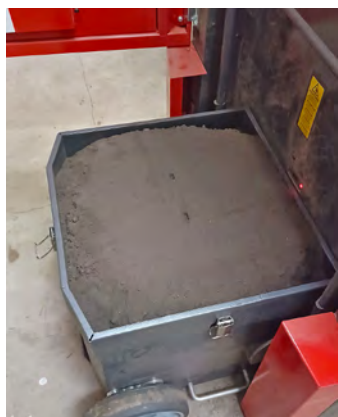
Aschekästen müssen regelmäßig geleert werden, die Menge hängt von der Qualität des Brennstoffs ab.
