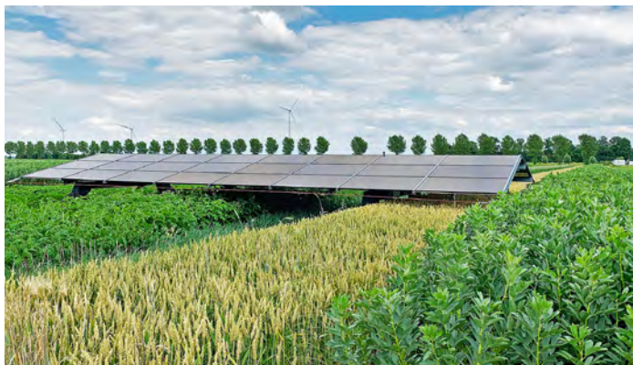
Mit dem mobilen Agri-PV-System soll weiterhin die gesamte Fläche des Feldes landwirtschaftlich genutzt werden können. Fotos: H2arvester
