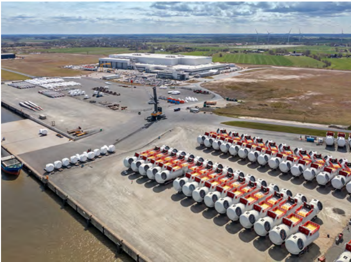
Das Turbinenwerk von Siemens Gamesa in Cuxhaven ist für die Offshore-Windkraftprojekte der Nordsee verkehrsgünstig gelegen.
