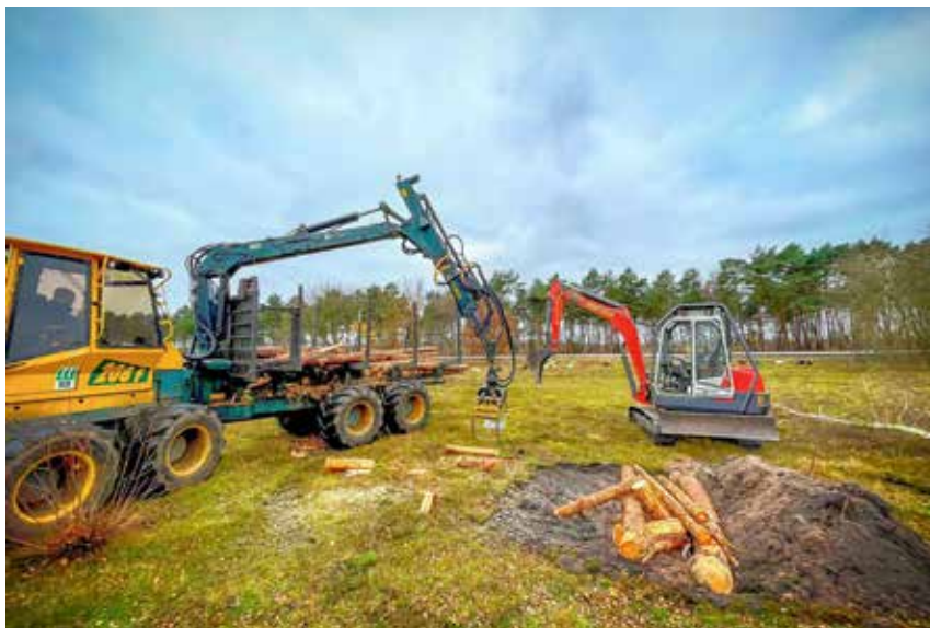
Bau eines Reptilienverstecks: Die Aufgaben der Lohnunternehmen werden vielfältiger, die Betriebspunkte ändern sich.
